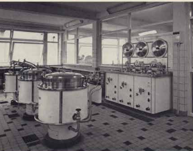
Küche. Fensterbänder mit großen Schwinglügelein und verglaste Zwischenwände gestatten eine gute Belüftung und Belichtung.
