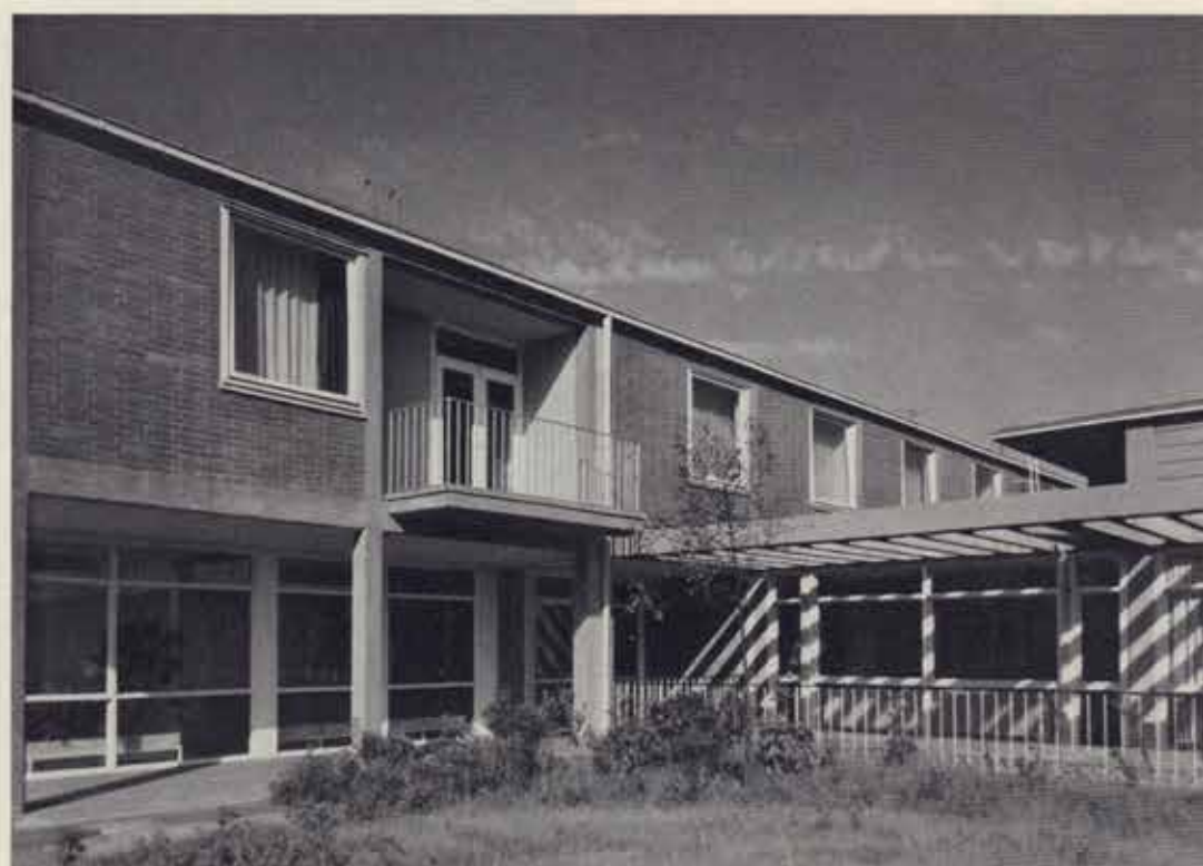
Hauptbau mit anschließendem Speisesaal.
