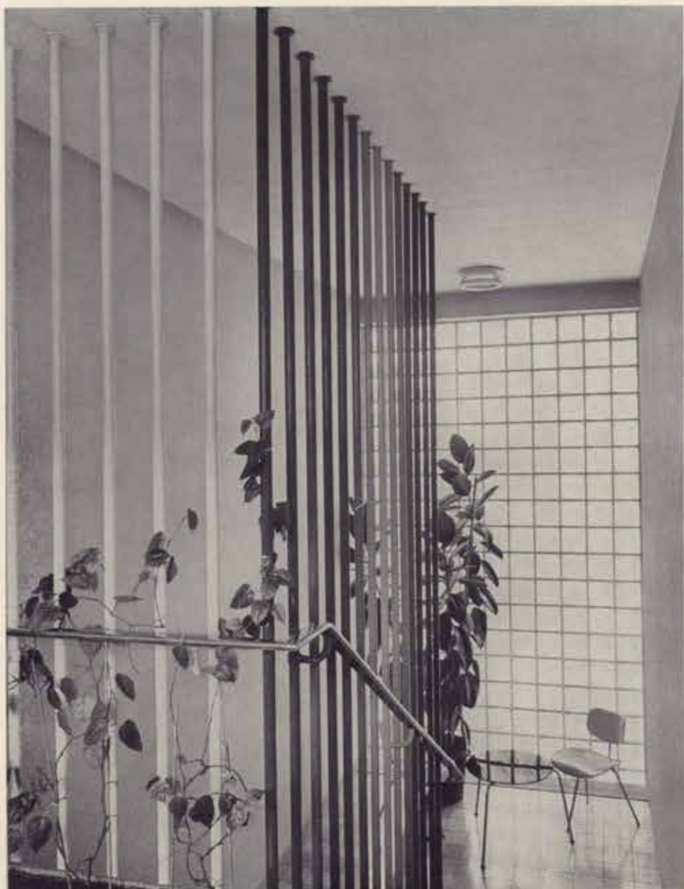
Blick in das Treppenhaus des Atelierhauses. Die durch- gehenden Rohrstäbe sind in den Farben des Regen- bogens lackiert. Verglasung der Stirnwand in Glas- bausteinen
