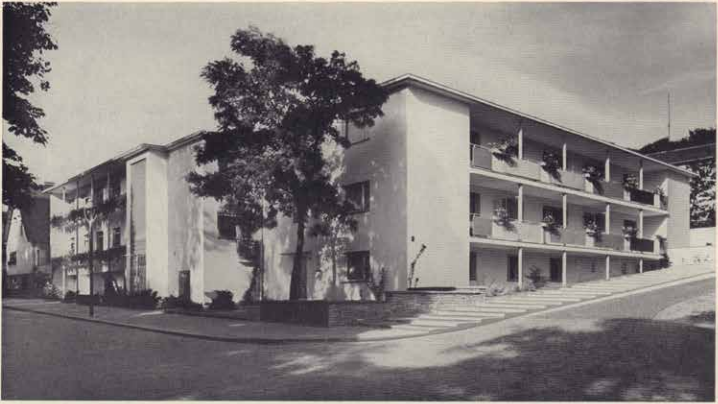
Ansicht der Baanlage von Südwesten. Rechts das Wohnhaus, links das Atelierhaus
