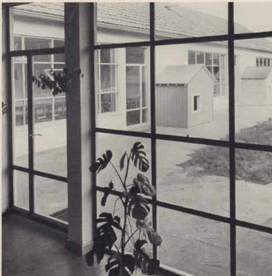
Blick aus dem Pausenflur auf den Flügel mit Aufenthalts- und Spielräumen Wing with the day-rooms and play-rooms area seen from recreation hall Aile des pièces de séjour et de jeux, vue de l'aire de récréation
